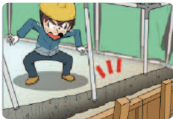
지반 침하에 의한 거푸집 동바리 붕괴
